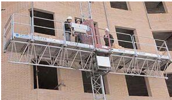
Ilustración 18. Andamio de elevación por cremallera ( Tomado de Monografias.com)
