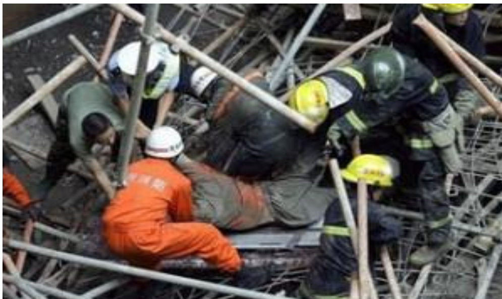
Ilustración 6. Accidente laboral por caída de andamio ( Diario Libre)
