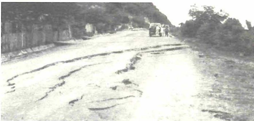
Efectos geotécnicos. Terremoto El Limón, Costa Rica.
