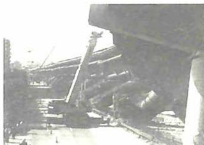
Viaducto en terremoto Kobe, Japón.
