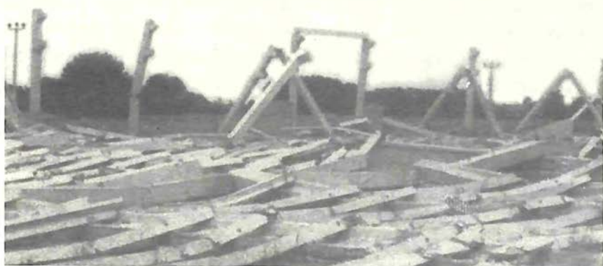
Daños Ed. prefabricado en Armenia.
