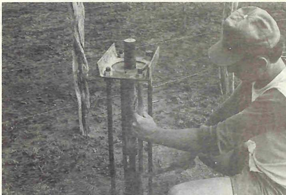
Fig. II-a Extracción de especímenes inalterados tomados con tubos de pared delgada.
