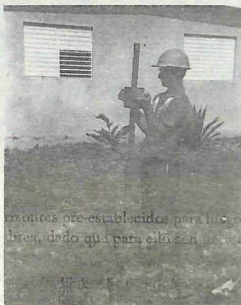
Fig. II-c. Operación del martinete de 16 Kg.
