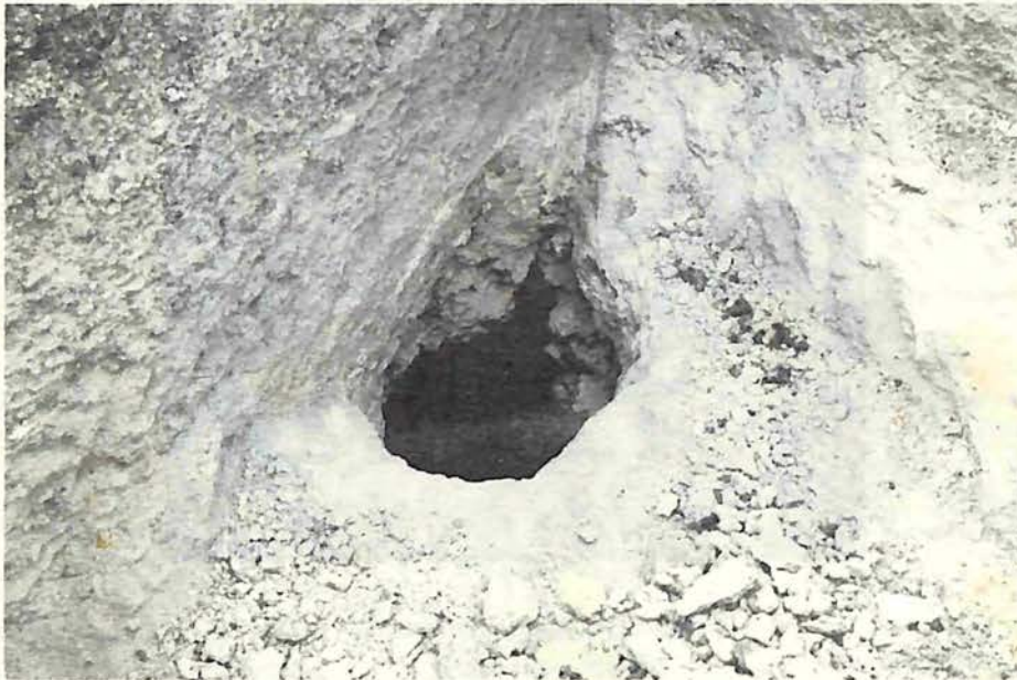
Fig. I-d Caverna en el plano de asiento de una zapata
