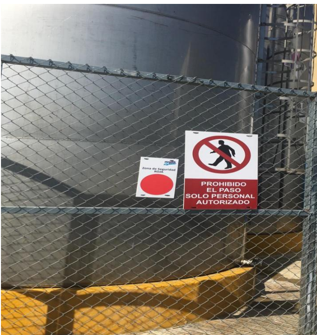
Área de almacenamiento
