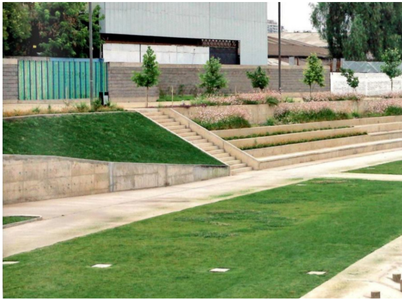
Imagen 92. Fotografía del actual Parque Inundable.
