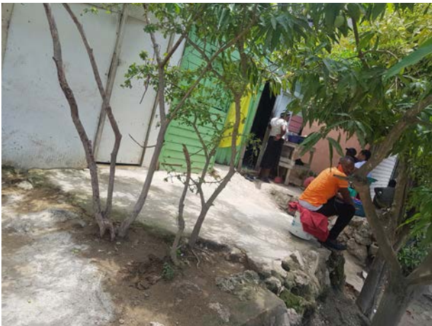
Imagen 176. Vivienda en mal estado.
