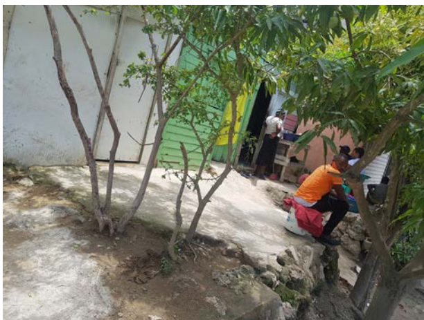
Imagen 158. Vivienda en mal estado.
