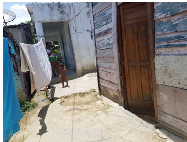
Imagen 167. Vivienda en mal estado.
