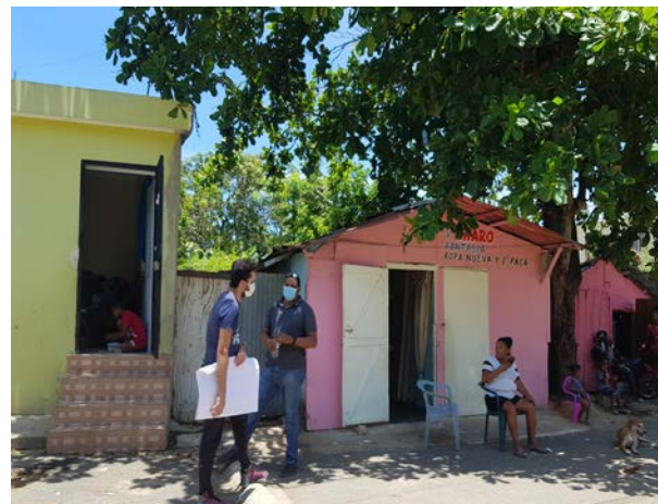
Imagen 185. Vivienda en mal estado.
