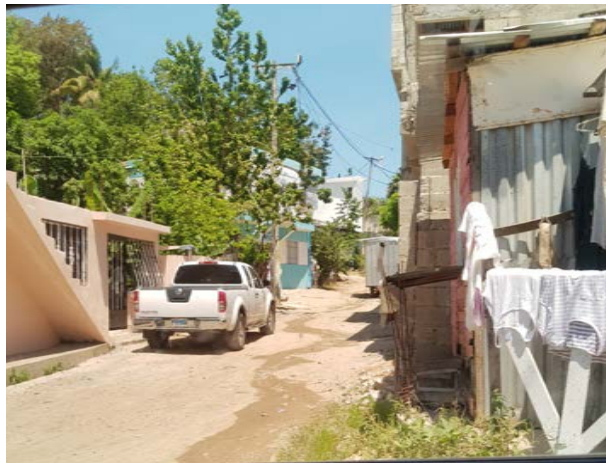
Imagen 147. Mal estado de las viviendas y calles
