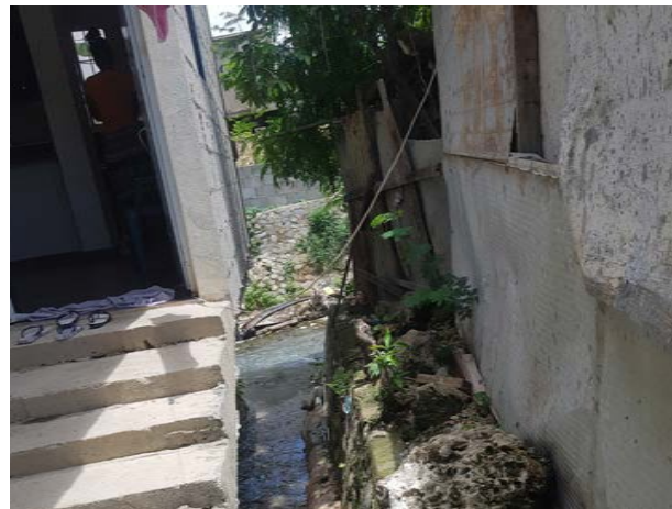
Imagen 123. Mal estado de el Arroyo
