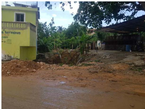
Imagen 129. Deslizamiento de tierra en la cañada que nace del arroyo.
