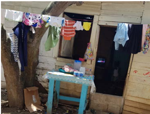
Imagen 161. Vivienda en mal estado.
