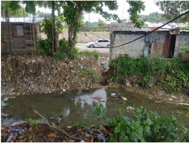
Imagen 119. Mal estado de el Arroyo.
