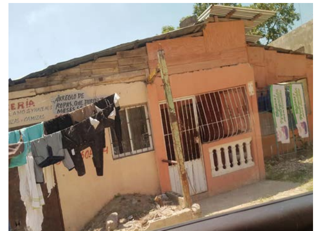
Imagen 186. Vivienda en mal estado.
