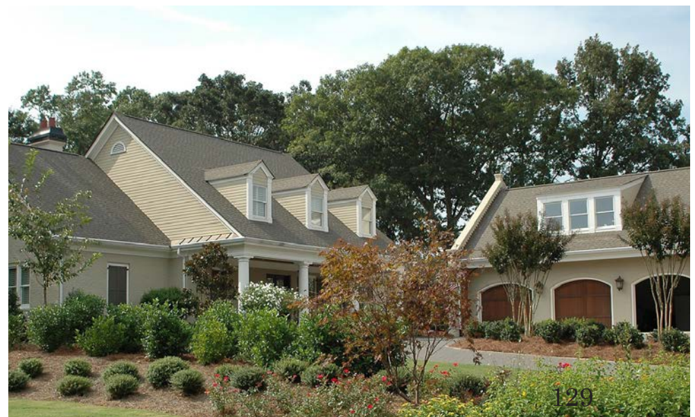
Imagen 81. Viviendas unifamiliares paralelas. Imagen de Paul Brennan en Pixabay
