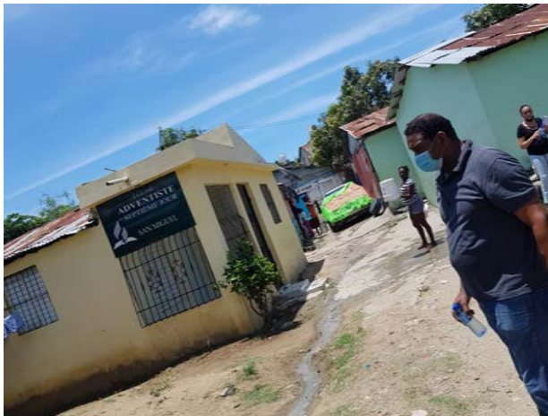
Imagen 181. Vivienda en mal estado.
