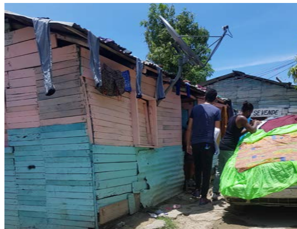
Imagen 165. Vivienda en mal estado.
