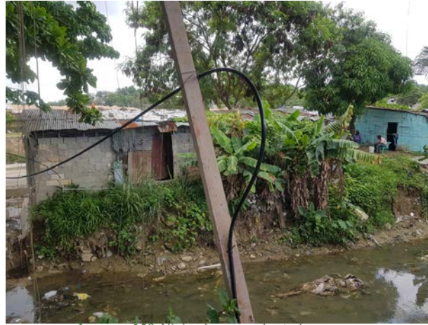
Imagen 153. Viviendas en mal estado
