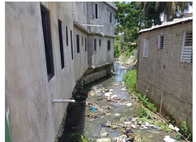
Imagen 124. Mal estado de el Arroyo
