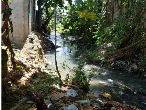
Imagen 144. Mal estado de el Arroyo
