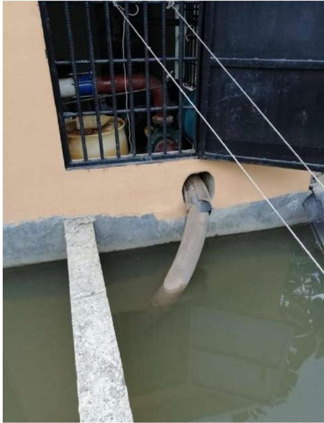
**Figura 27:** Tubería de succión desde reservorio hacia la motobomba.
