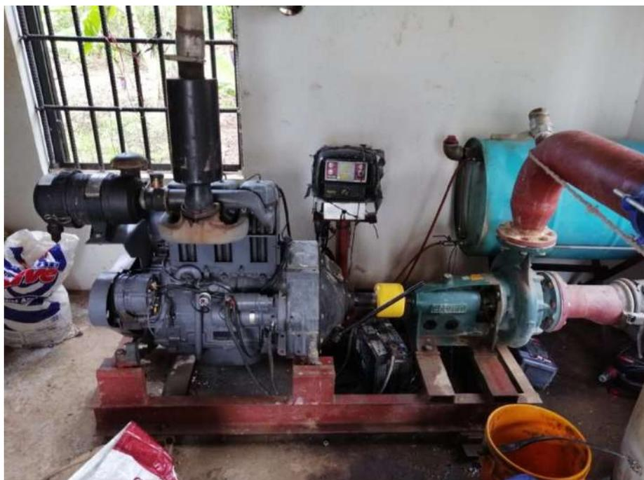
**Figura 28:** Motobomba Diesel.
