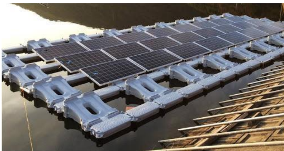
Ilustración 19: Sistema solar flotante Hydrelío.
