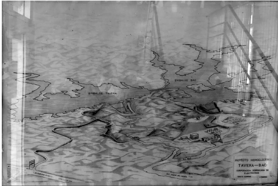
Ilustración 41: Proyecto hidroeléctrico Tavera-Bao (Fuente: Propia 2021)
