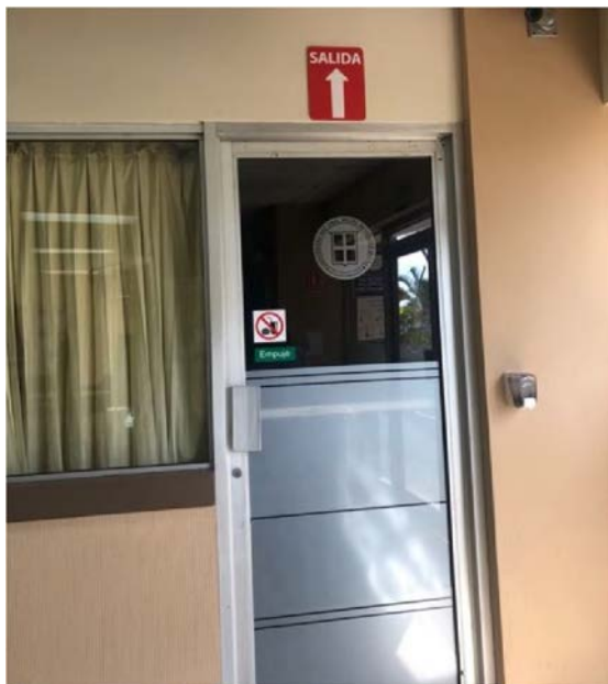
Figura 14. Fotografía tomada en la biblioteca, señalización de salida ubicada en el piso 1 del edificio 3, Salón de Conferencias
