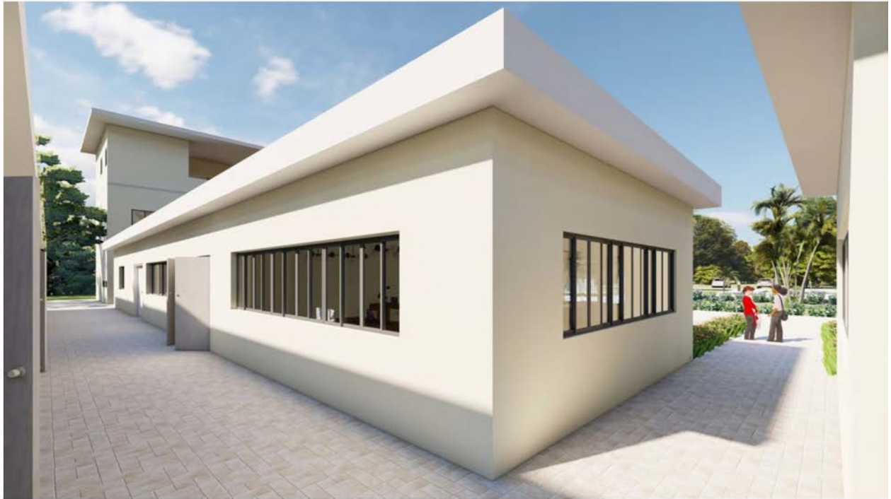
Ilustración 21. Vista Edificio - Oficina psicólogo – Creación Propia.
