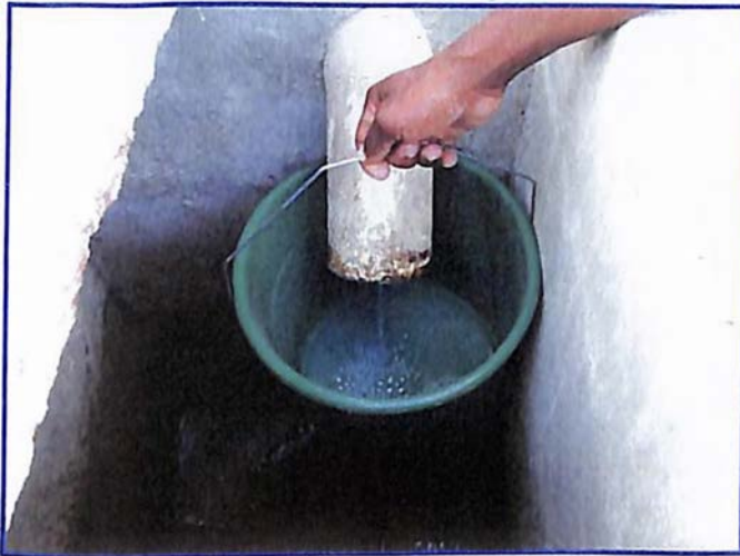
Medición de caudales en Registro Edificio Administrativo y de Empleados
