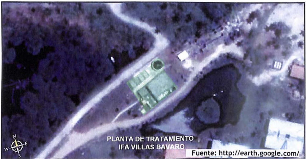
Figura 3-3: Foto aérea de ubicación PTAR del Complejo Hotelero
