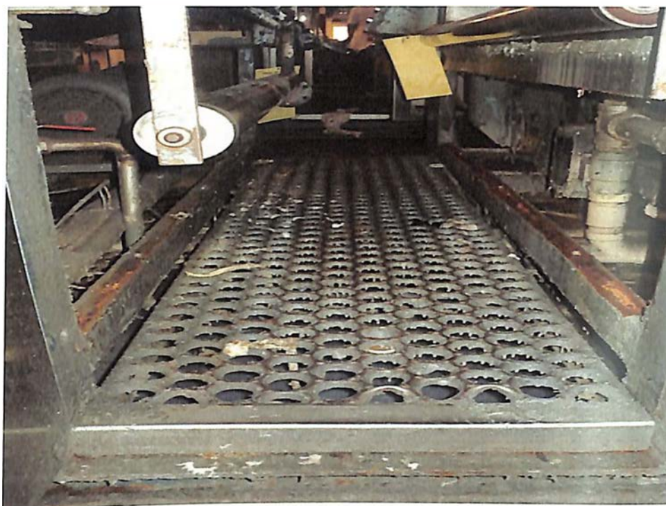
Figura 31: Parrilla Contaminada antes.
