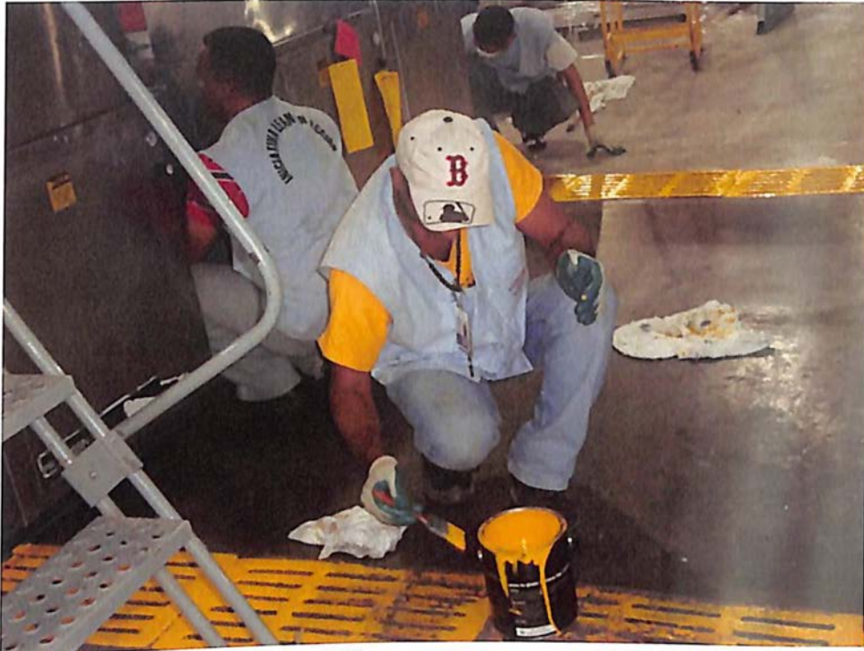
Figura 14: Pintura de la rejilla de desagüe.
