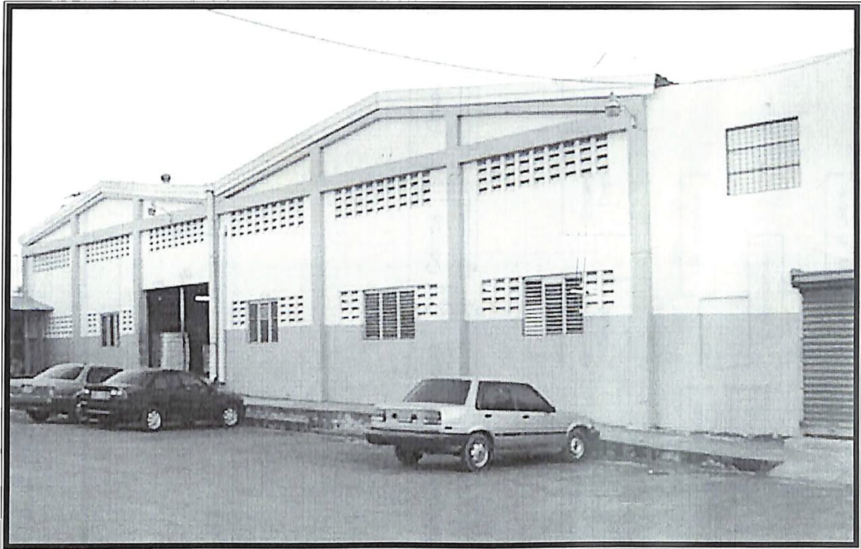
Parte Frontal de la Planta de Producción de Plastifar S.A.
