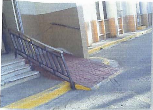
Escalera y rampa
