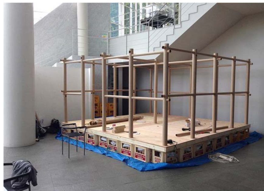
Estructura del tubo de papel
