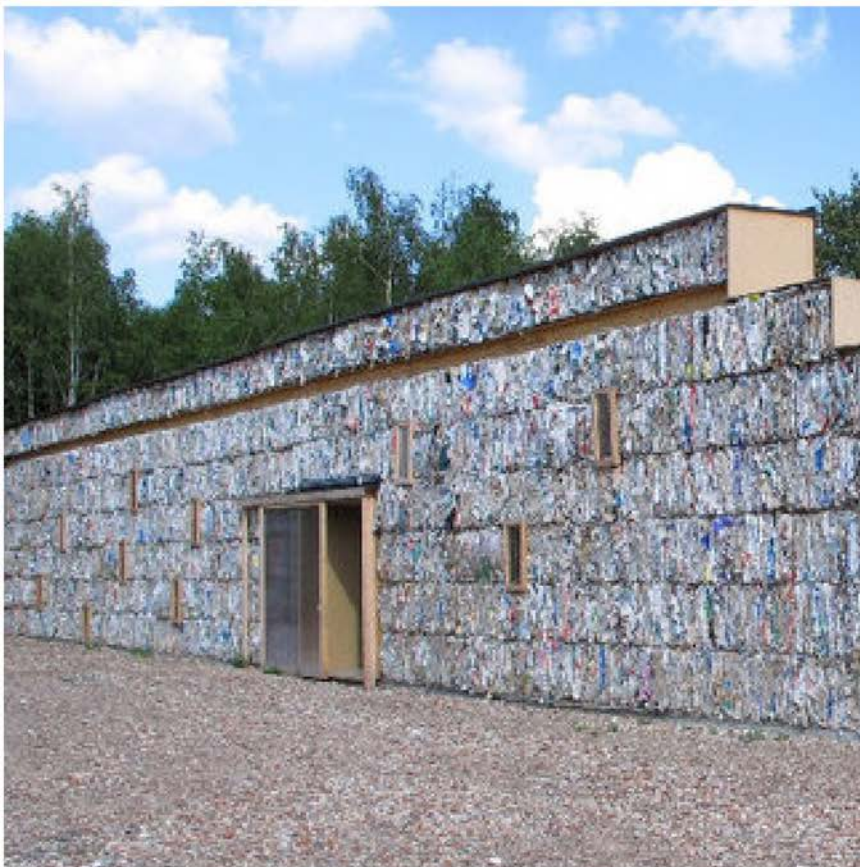
Figura #53. Dratz&Dratz Architekten (2012). Edificio temporal de oficinas se construye de fardos de papel reciclado en Essen.
