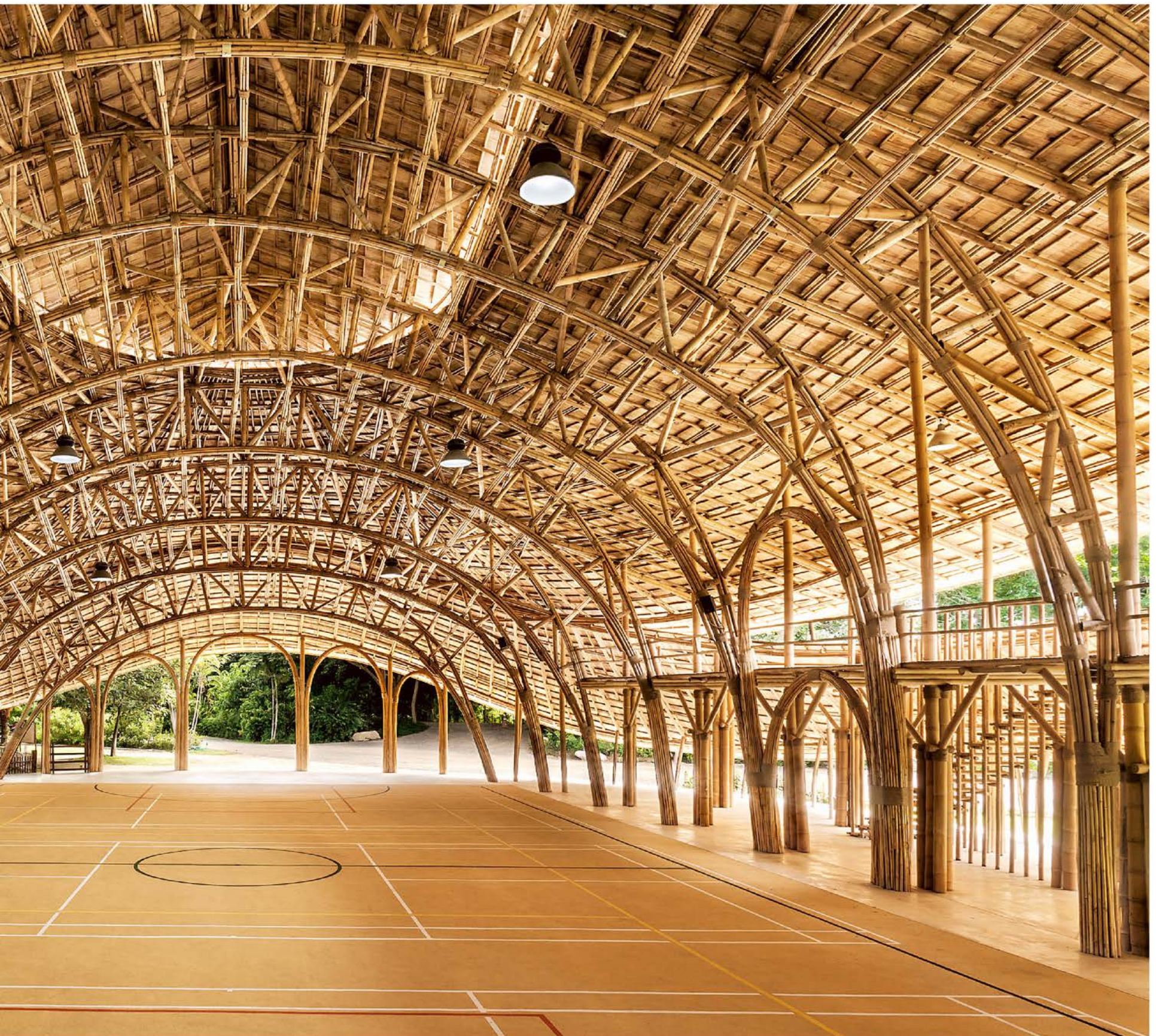
Figura #33. Cosi ,A. (2017). Pabellón deportivo, Escuela Internacional Panyaden, Namprae..
