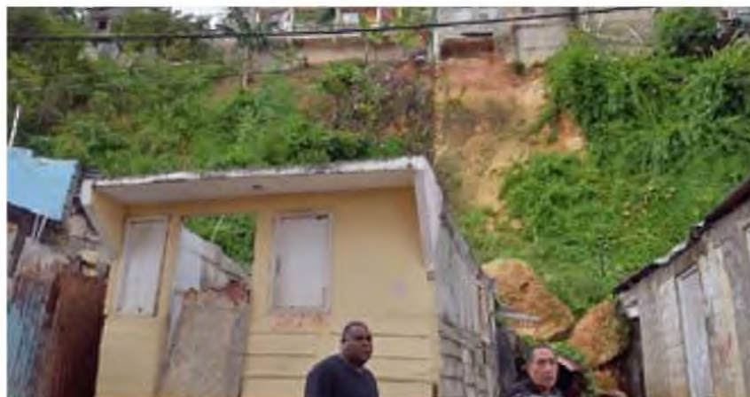
52. Imagen: Zonas de deslizamiento. Fuente: El Caribe
