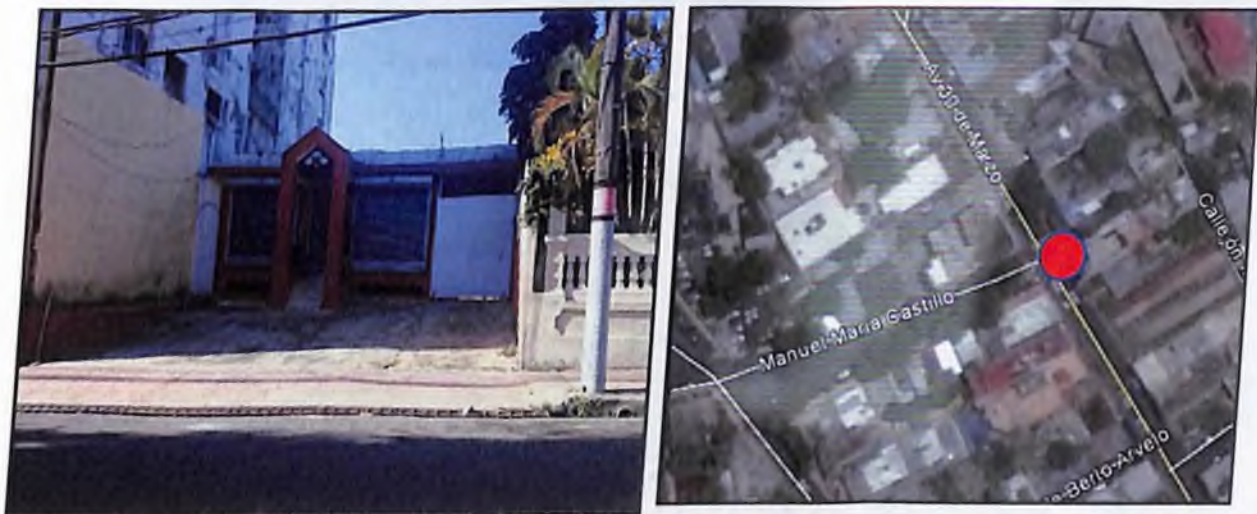
Fotografía No. 12 – Edificio de 1 nivel, Ubicación: Av. 30 de marzo casi esq. Manuel Castillo (al lado Edificio de 5 niveles)
