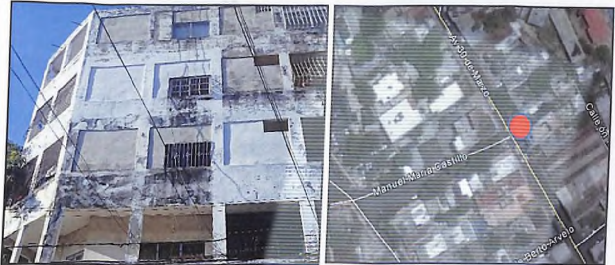
Fotografía No. 11 – Edificio de 5 niveles, Ubicación: Av. 30 de marzo esq. Manuel Castillo
