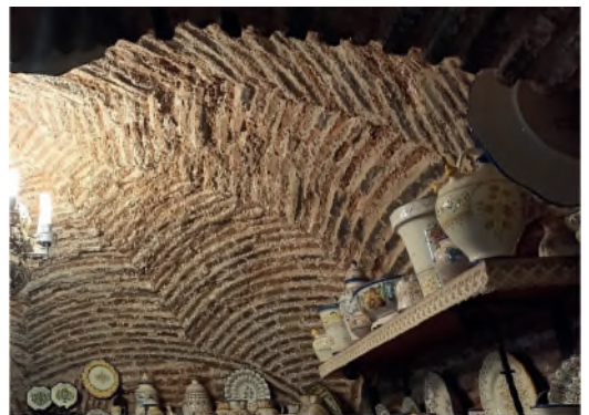
Figura 9 Bóveda ochavada en la llamada Casa de Bazanas, Toledo (fotografía de Elena Ruyra)
