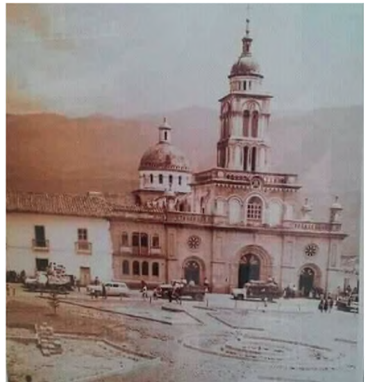
Figura 3 Templo terminado. (Fuente: Parroquia de Ancuya)
