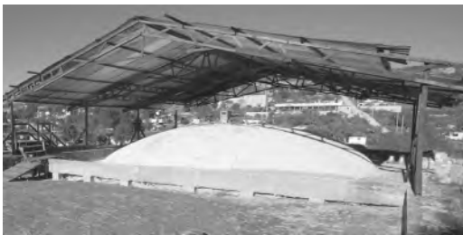
Figura 1 Fotografía del extradós de la bóveda con la techumbre metálica y traveses de concreto armado, (foto 2021)
