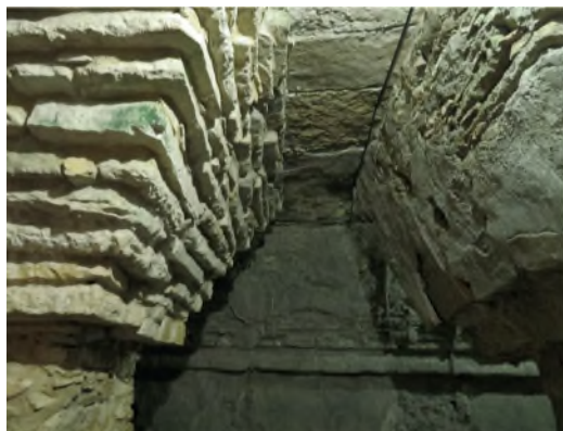
Figura 9 Galería subterránea donde se observa la aproximación de hiladas formadas por lajas de piedra y la tapa superior de la bóveda que cierra el espacio. Palenque (Foto de la autora)
