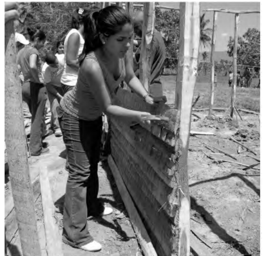
Figura 11 Proceso de clavado de las tablas de palma. (Fuente: Esteban Prieto Vicioso)
