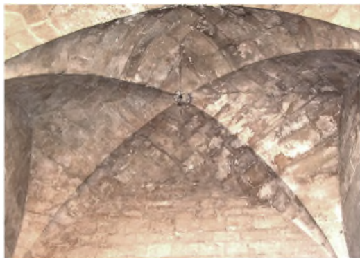
Figura 12 Bóveda en las torres de Quart, Valencia
