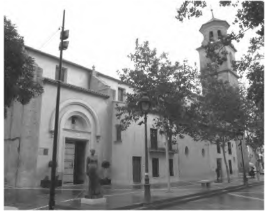
Figura 1 Vista general del exterior de la Iglesia de La Purísima Concepción, en Caravaca de la Cruz
