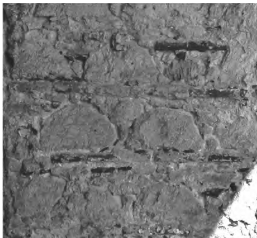
Figura 7 Paramento interior de la ampliación de cortina norte en donde se observa el uso de hiladas de piedra de coral alternadas con hiladas de ladrillo a modo de verdegadas. (Fotografía de la autora)
