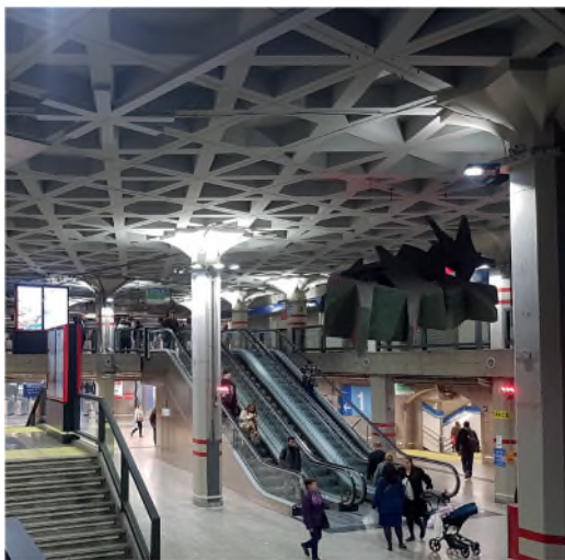
Figura 14 Losa vestíbulo estación de Sol. 1987. F. Candela. (Autor)
