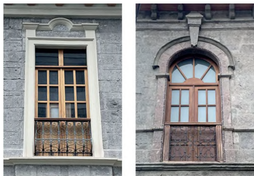
Figura 11 Ambato. Detalles arquitectónicos en piedra. Casas de las calles Rocafuerte y Montalvo, (Izq.) Ventana balcón con adintelado plano; (Dcha.) Ventana balcón con adintelado en arco de medio punto (Foto del autor 2022)
