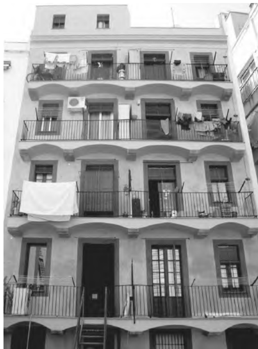
Figura 16 Rehabilitación de la fachada posterior del edificio en la calle Marqués Barberá 26, en Ciutat Vella, Barcelona. Balcones formados por bóvedas tabicadas sobre ménsulas de piedra. (Fuente GTA Europa. Rehabilitació d'edificis)
