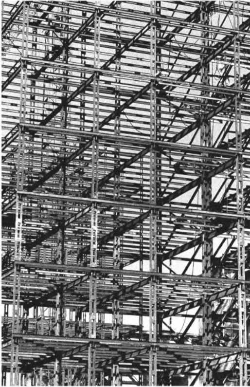
Figura 4 Estructura metálica del Diario Pueblo en construcción (Bergera 2005: 236)
