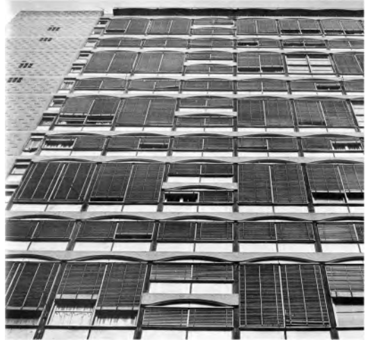
Figura 18 Galería Rivadavia. Bóvedas superpuestas en fachada, a la catalana según Bonet Castellana. (Katzenstein, Natanson, y Schwartzman 1985)
