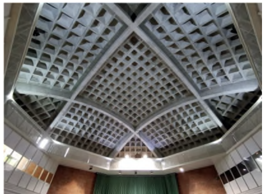
Figura 5 Pabellón Central Feria Internacional Ganadera, Zafra. (Autor)
