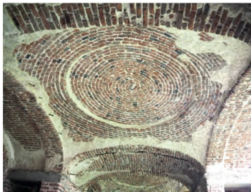
Figura 7 Bóveda plana por hiladas circulares en la Galería de las Grutas de la Casa de Campo
