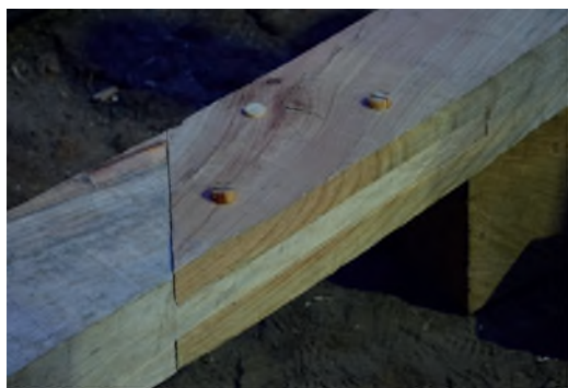
Figura 13 Sistema de ensamble en cornezuelo para unir los cerchones que forman las nervaduras (Fotografía: Luis Torres G. 2022)
