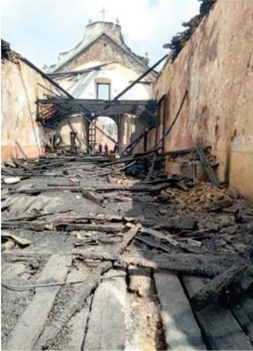
Figura 15 Vestigios observados del sistema constructivo del piso de madera encajonado (Fotografía: templo_nurio_x4x_crop16 16386564510.jpeg_242310155 consultado: 6/09/2021)
