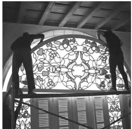
Figura 9 Montaje del vitral central después de su reconstrucción. (Imagen tomada por el autor)
