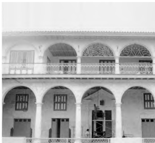
Figura 4 Imagen de la fachada durante la restauración dirigida por el Maestro Arquitecto Daniel Taboada, posterior a 1975. (Archivo Histórico de la Oficina del Historiador de La Habana)
