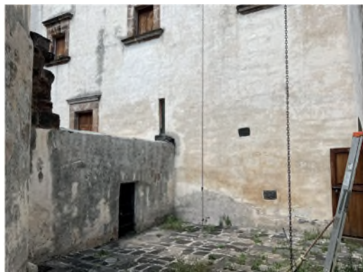
Figura 3 Aljibe de Tzintzuntzan Michoacán, semienterrado. Lo que sobresale del terreno es la bóveda de cañón, la cual es un gran captador de agua al que llegan también las descargas de las azoteas por medio de gárgolas de barro, también es perceptible la ventana para la toma del agua. Fotografía. (Pastrana 2022)
