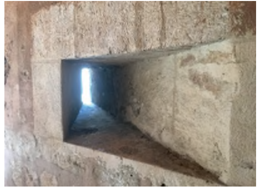
Figura 3 Aspillera. Torre del Homenaje, Fortaleza de Santo Domingo
