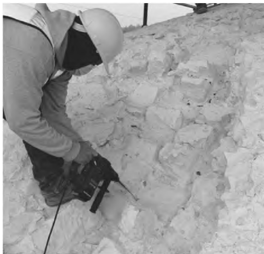
Figura 7 Fotografía de los taladros para cala 1 solicitada por el autor en 2021
