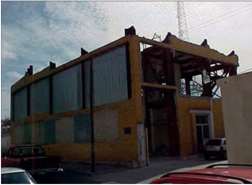
Figura 2 Sistema constructivo a base de estructura metálica en el edificio de máquinas de la ex Compañía de Luz y Fuerza Eléctrica. (Archivo Arturo Román)
