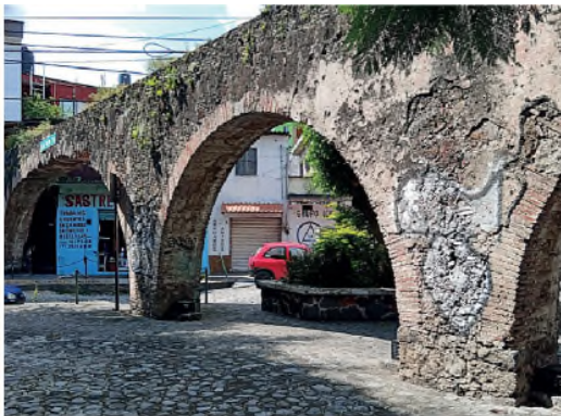
Figura 7 Vista del estado actual del acueducto: (a) arco carpanel al fondo y arco semicircular central, (b) vista de un arco semicircular en el primer plano y de la parte superior del tímpano de los arcos desaparecidos entre las viviendas
