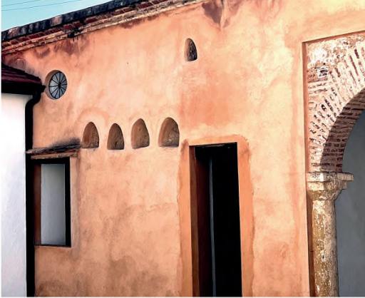
Figura 7 Palomares. Dos grupos de nidas de palomares en un muro de tapial que originalmente debió tener varias decenas. (Foto del autor)
