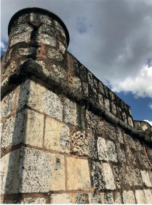
Figura 15 Muro de sillería. Baluarte de San José
