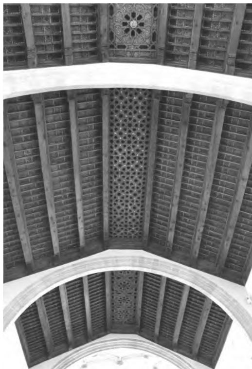
Figura 2 Vista general de la techumbre de madera de la Iglesia de La Purísima Concepción
