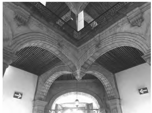
Figura 4 Doble arco tranquil interceptado con la piedra clave invertida a modo de pinjante. Antiguo Palacio de la Inquisición. (Fotografía: A. Contreras. Agosto, 2018)
