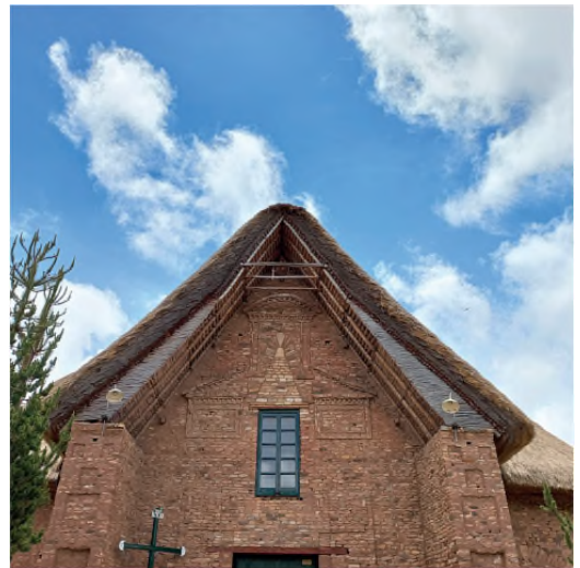
Figura 8 Detalle del encuentro del muro de hastial con la cubierta de par y nudillo en la iglesia San Pedro de Ninacaca, que también aparece en los dibujos de Guamán Poma. (Hurtado Valdez, P.)
