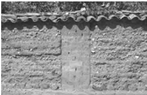
Figura 3 Pilar de adobe entre muros de tapia desnuda
