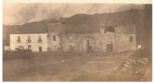
Figura 2 Templo en proceso de construcción. (Fuente: Parroquia de Ancuya)
