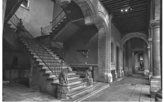
Figura 8 Arranque de la escalera del Antiguo Palacio de los Condes de Santiago de Calimaya. (Foto: Alejandra Contreras, mayo 2018)
