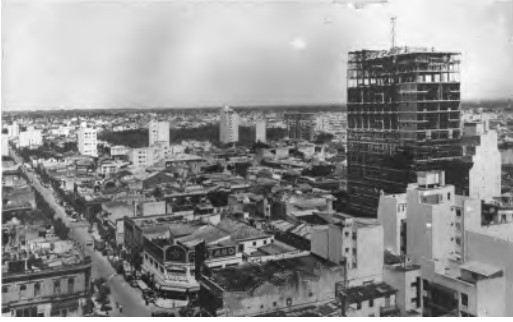
Figura 3 Torre de la Galería Rivadavia en construcción. Archivo Antoni Bonet Castellana. Archivo Histórico del Colegio Oficial de Arquitectos de Cataluña
