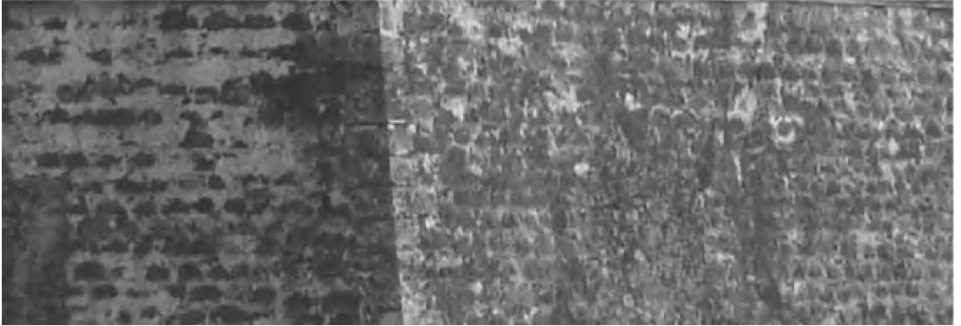
Figura 6 Vista de un fragmento de la cara norte y flanco noreste del baluarte de San Pedro en donde se observan las hiladas de piedra de coral. Fotografía de la autora
