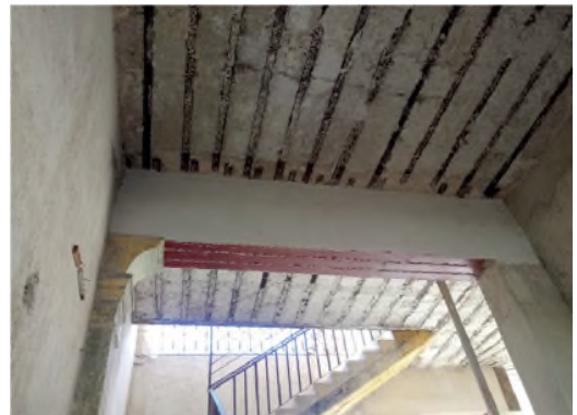
Figura 5 Techumbre de viguetas metálicas y concreto armado como solución de plafón liso en la casa de las Cariátides en Mérida donde también se observa la trabe mixta de viguetas metálicas soportando un conglomerado de piedras y mortero de cal, Yucatán. (Archivo Arturo Román).
