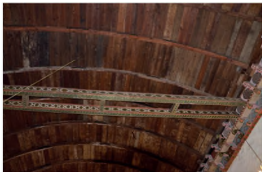
Figura 12 Gualdras de amarre y sujeción del sistema (Fotografía: Luis Torres G. 2013)
