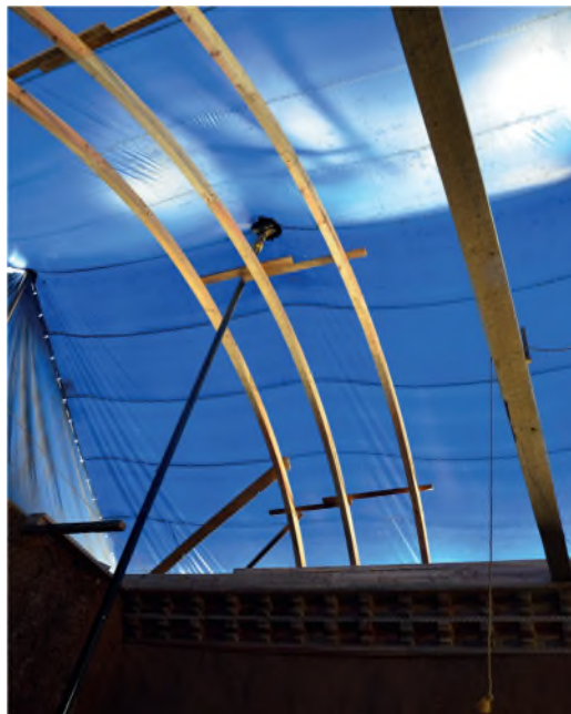
Figura 14 Colocación de las nervaduras y ensamble con sistema de caja y espiga sobre los arrastres (Fotografía: Luis Torres G. 2022)
