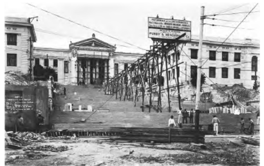
Figura 9 Proceso de construcción para la escalinata monumental de entrada para la Universidad de La Habana. 1927. Secretaría de Obras Públicas - Negociado de Construcciones Civiles y Militares, La Habana
