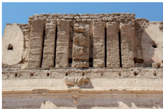
Figura 7 Detalle de las improntas de las cerchas que estructuraban la bóveda de medio cañón corrido sobre la nave con los lunetos en ambos extremos. (Amorós 2019)
