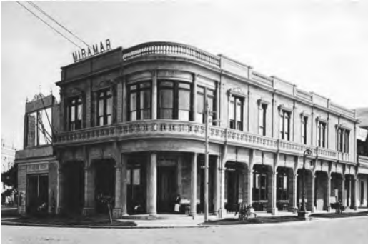
Figura 5 Vista del Hotel Miramar y su portal circundante. 1914. Revista El Figaro, La Habana
