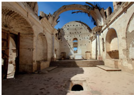
Figura 3 Nave única con el acceso a la cripta y la capilla mayor elevada por cinco escalones. (Negro 2019)
