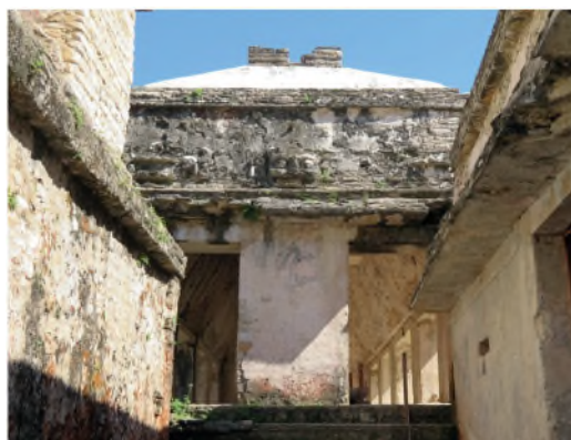
Figura 10 Patio del palacio de Palenque donde se observa el vuelo de la cornisa, el dintel de los huecos del muro exterior y las cubiertas inclinadas con bóveda por aproximación cubriendo el espacio interior (Foto de la autora)
