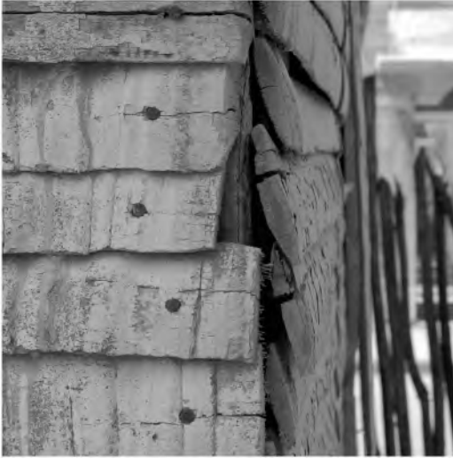
Figura 10 Tablas de palma fijadas con clavos (Fuente: Esteban Prieto Vicioso)
