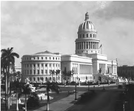
Figura 10 Vista lateral del Capitolio. 1930. Secretaría de Obras Públicas - Negociado de Construcciones Civiles y Militares, La Habana
