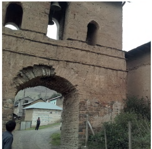
Figura 9 Paramentos de piedra rústica y adobe en la torre exenta de la iglesia San Juan de Yacán. (Hurtado Valdez, P.)
