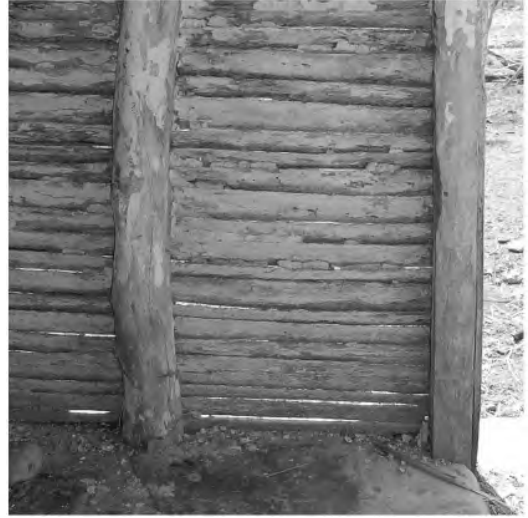
Figura 2 Estantes de una edificación de tabla de cana de 1840 (Flores Sasso 2007)
