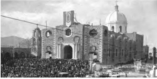
Figura 3 Fotografía del edificio en su proceso de construcción, donde es posible observar la cúpula gallonada sobre un cimborrio de base octagonal. (Fuente: https://diocesisciudadjuarez.com/ )
