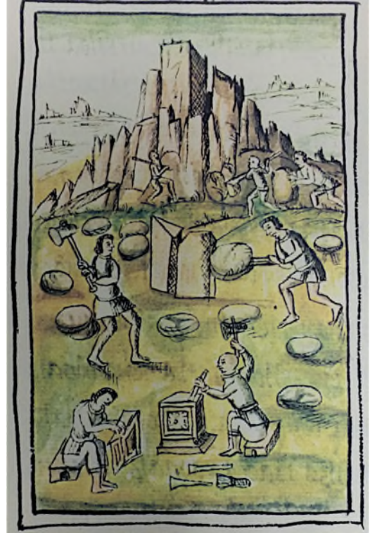
Figura 5 Ilustración de indígenas trabajando en la extracción y labrado de cantera. (Sahagún 1578)
