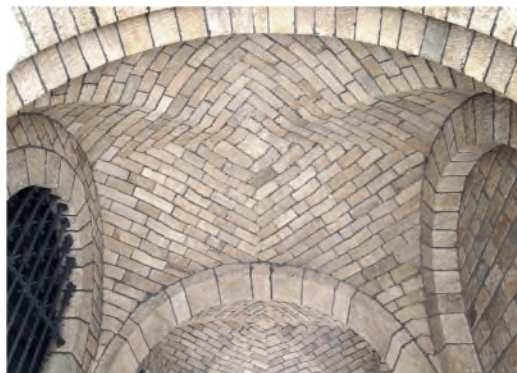
Figura 13 Bóveda de piedra en un pasaje de la ciudad de Aquisgrán
