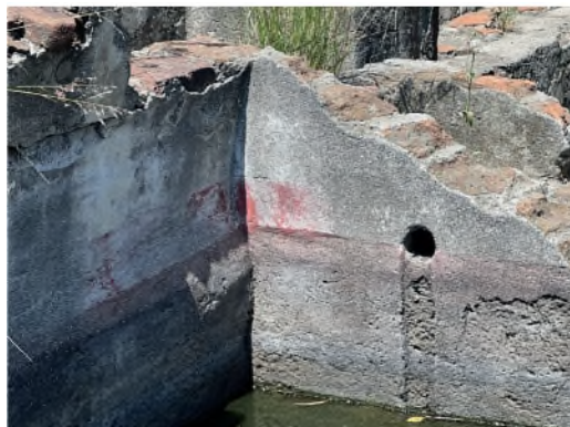
Figura 5 Alberca en la huerta del antiguo convento franciscano de Huejotzingo en Puebla. Son perceptibles los agregados típicos del « opus signinum », fotografía (Pastrana 2023)
