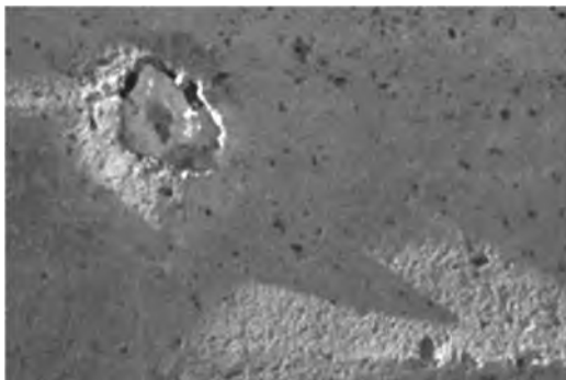
Figura 7 Costra de cal en una tapia
