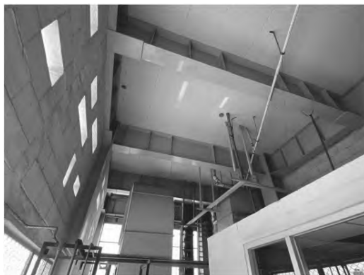
Figura 6 Estructura de acero, losas de concreto armado y muros de block de concreto (Archivo de J. Jesús López García)
