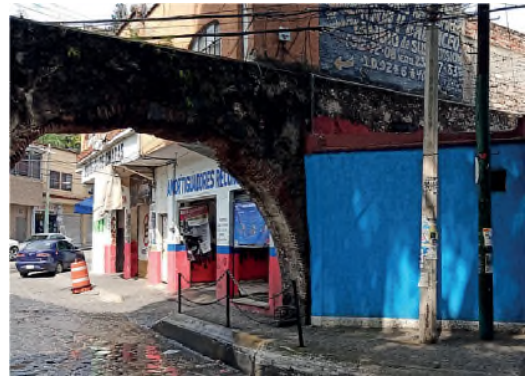
Figura 7 Vista del estado actual del acueducto: (a) arco carpanel al fondo y arco semicircular central, (b) vista de un arco semicircular en el primer plano y de la parte superior del tímpano de los arcos desaparecidos entre las viviendas
