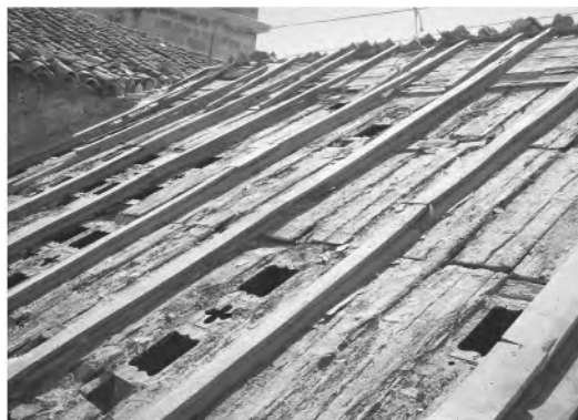
Figura 6 Trasdós del faldón de cubierta durante las obras de restauración. Destaca la solución de cinta y saetino así como la colocación de listones sobre los pares, dejando finalmente una pequeña cámara de ventilación
