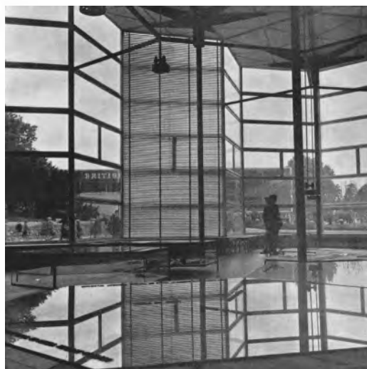
Figura 8 Vista desde el interior del cierre acristalado de perfiles de aluminio del Pabellón de España en Bruselas (Molezún 1958:9)
