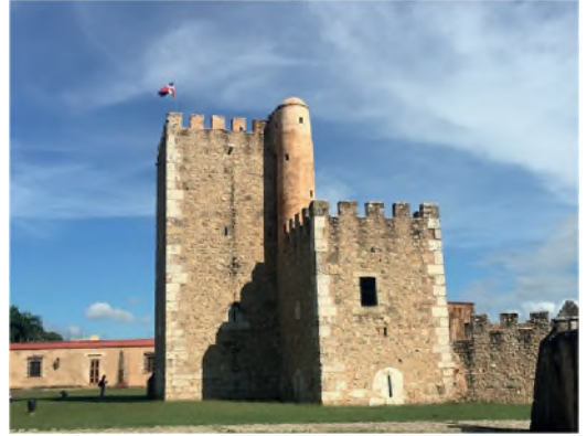
Figura 2 Torre del Homenaje, Fortaleza de Santo Domingo, fachada sur
