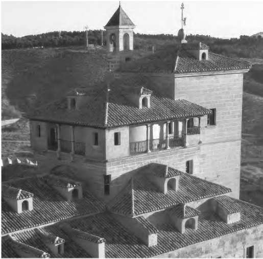
Figura 6 Vista actual del cimborrio que envuelve la cúpula de la iglesia
