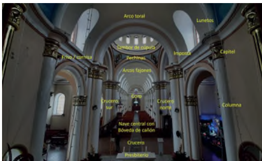
Figura 10 Sistema estructural del templo. (Foto: William Pasuy Arciniegas)
