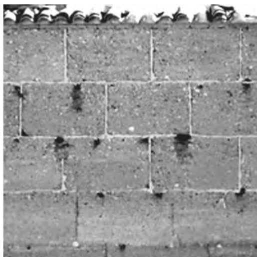
Figura 5 Tapia de juntas reforzadas
