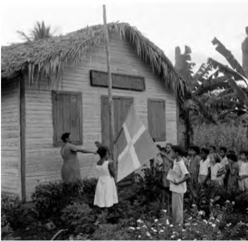
Figura 7 Escuela rural de tabla de palma y cubierta de Cana de 1959
