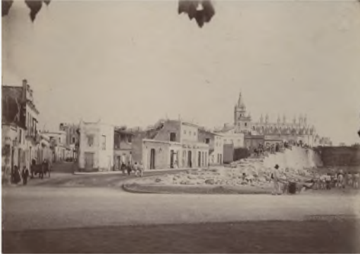
Figura 13 Fotografía de 1889 mostrando el avance de los trabajos de demolición de las murallas en la Avenida de Miraflores, con la iglesia de Paula al fondo (Fototeca de Cuba).
