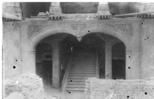
Figura 10 Imagen del doble arco tranquil que estuvo en la escalera principal de la Universidad Real y Pontificia de México. (Referencia: Fototeca INAH)
