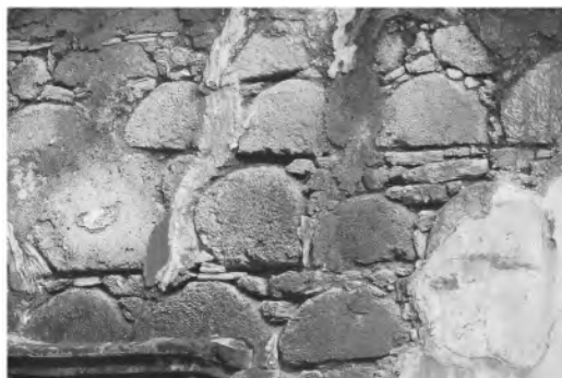
Figura 8 Mamposterías semi irregulares de coral. (Fotografía de la autora)
