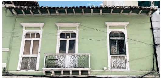
Figura 8 Ambato. Casa particular, calles Montalvo y Vela. Fachada de bahareque con enmarcaciones decorativas de madera (Foto del autor 2022)
