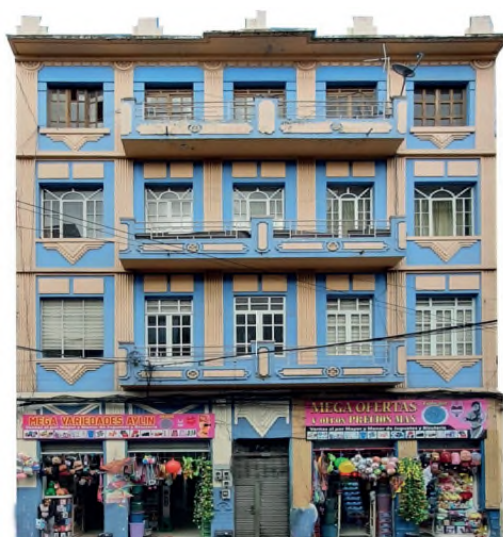
Figura 15 Ambato. Edificio particular de estilo Art Decó, calles Vela y Egúez (Foto de los autores 2023)
