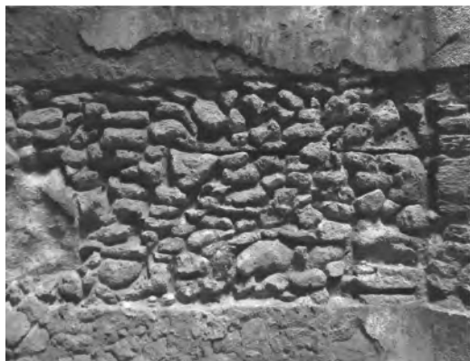
Figura 4 Detalle de las mamposterías irregulares que datan del siglo XVI y corresponden con la ejecución de las obras de Cristóbal Eraso según exploraciones arqueológicas de Judith Hernández Aranda. Fotografía de la autora.
