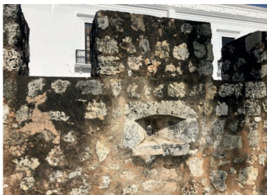
Figura 5 Muralla de la Fortaleza de Santo Domingo. Mampostería
