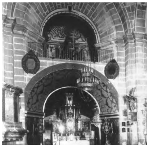
Figura 5 Arcos abocinados de cantería con generatriz parabólica de la capilla mayor
