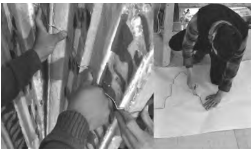
Figura 4 Fotografía del proceso de calca del perfil de los nervios mediante un hilo de estaño y cartulina, gracias a plataforma colocada por TZAPOTECATL en 2021-22
