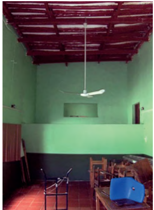
Figura 1 Sistema constructivo tradicional con apoyos de mampostería de piedra y cubierta de rollizos con bahpek en la ex escuela primaria “Benito Juárez”, Tekit, Yucatán. 1886. (Archivo Sofía Ayora)
