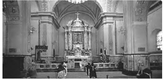
Figura 4 Interior de templo parroquial con vista hacia el presbiterio, todavía con el altar pegado al muro testero y una cubierta de bóveda de arista construida con concreto armado. (Fuente: https://diocesisciudadjuarez.com/ )
