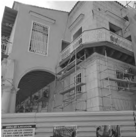
Figura 8 Trabajos de restauración en la fachada. (Imagen tomada por el autor)
