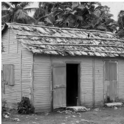
Figura 12 Bohío de tabla de palma cobijado con yaguas. (Fuente: Esteban Prieto Vicioso)
