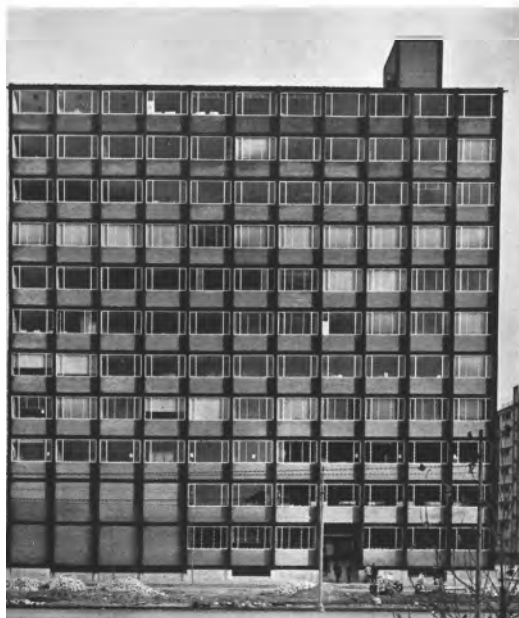
Figura 7 Vista del alzado de la fachada del Edificio Arriba (Cabrero 1964:23)
