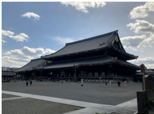
Figura 1 Templos budistas de Higashi Hongan-Ji en Kioto Japón. Es perceptible la estilización de la techumbre para desalojo, captación de agua de lluvia y evitar la acumulación de nieve, fotografía. (Pastrana 2018)
