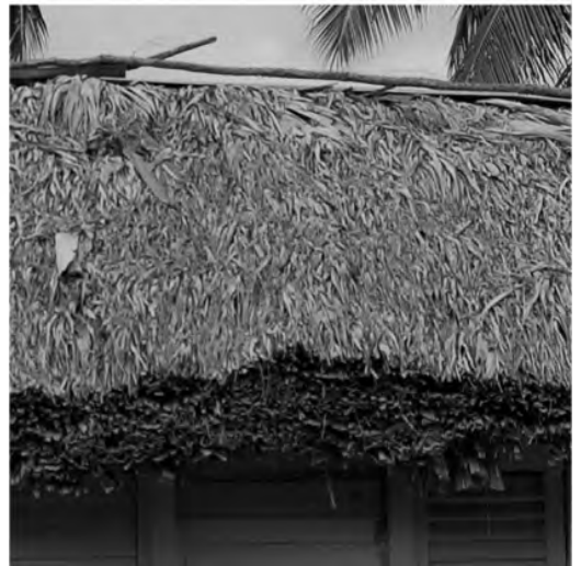
Figura 5 Cubierta de cana de un bohío (Prieto Vicioso 2013)
