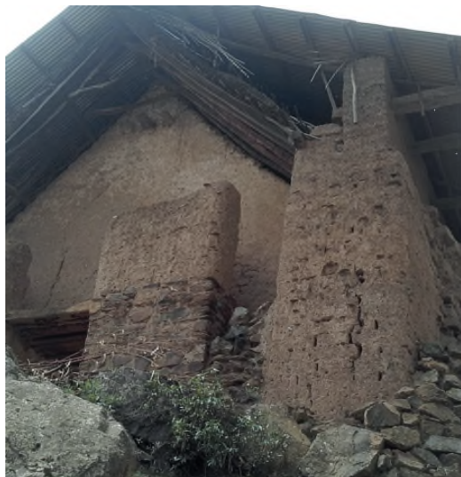
Figura 10 Estructura de par y nudillo con encuentro triangular entre el hastial de fachada y la cubierta en la iglesia San Juan de Yacán. (Hurtado Valdez, P.)
