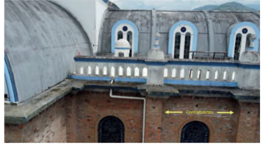
Figura 11 Contrafuertes muros naves laterales. (Foto: William Pasuy Arciniegas)
