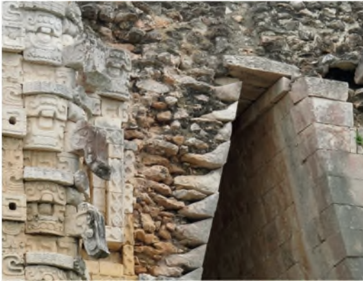
Figura 11 Arco en el Palacio del Gobernador de Uxmal mostrando el relleno del muro de mampuesto, las piezas que conforman el arco por aproximación y la decoración Puuc (Foto de la autora)
