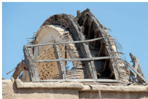
Figura 8 Estructura de cerchas, camones y correas con cerramiento de cañas partidas en la bóveda de medio cañón corrido sobre la nave. (Amorós 2019)
