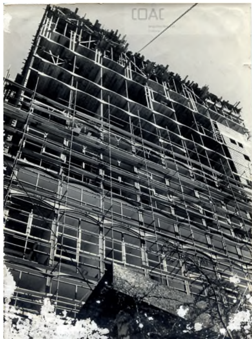
Figura 15 Galería Rivadavia. Bóvedas-jácena de hormigón armado superpuestas en construcción. (Archivo Antoni Bonet Castellana. Archivo Histórico el Colegio Oficial de Arquitectos de Cataluña)
