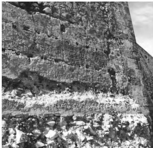
Figura 3 Arranque de la torre Chacona antes de la intervención de 2001
