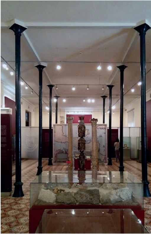
Figura 8 Vista de áreas del actual Museo de la Ciudad del Ex Palacio Federal donde se observa la estructura a base de columnas de hierro fundido, traveses y losas de concreto armado (Archivo Arturo Román)
