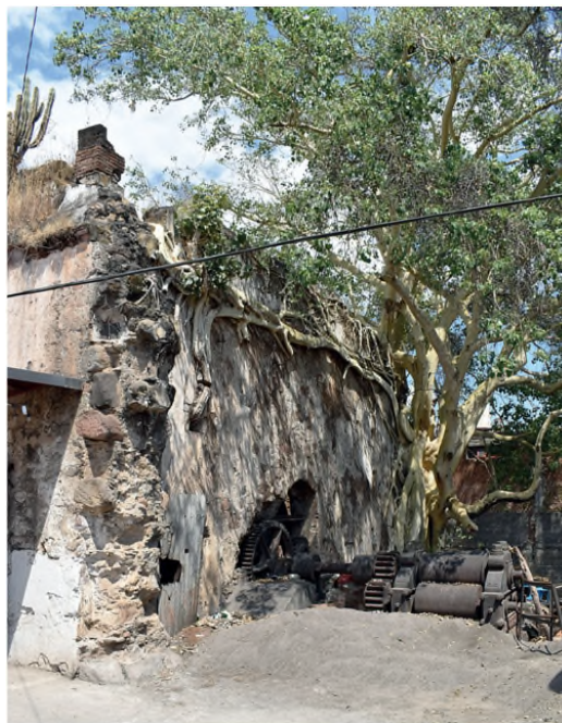
Figura 2 Vestigios del cárcamo, rueda hidráulica y trapiche horizontal de hierro de tres mazas de la casa del molino de la hacienda de San Nicolás Chupio. (Fuente: Archivo personal, 2022)
