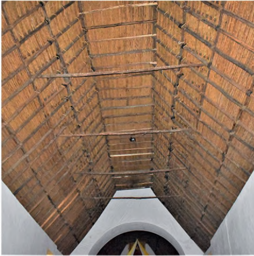
Figura 7 Cubierta de par y nudillo en la iglesia San Pedro de Ninacaca, con estructura de rollizos y caña. (Hurtado Valdez, P.)
