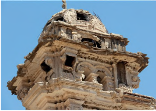
Figura 5 Detalle de la estructura del segundo cuerpo de campanas con el tambor coronado por un cupulino de media naranja en obra de madera y cañas partidas. (Negro 2018)
