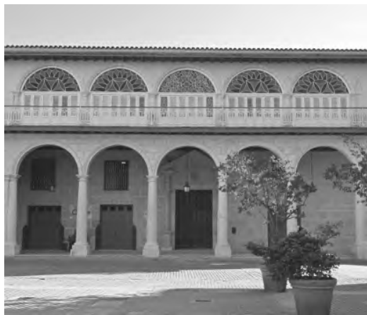
Figura 12 Fachada restaurada en la 1ra etapa de intervención. (Imagen tomada por el autor)
