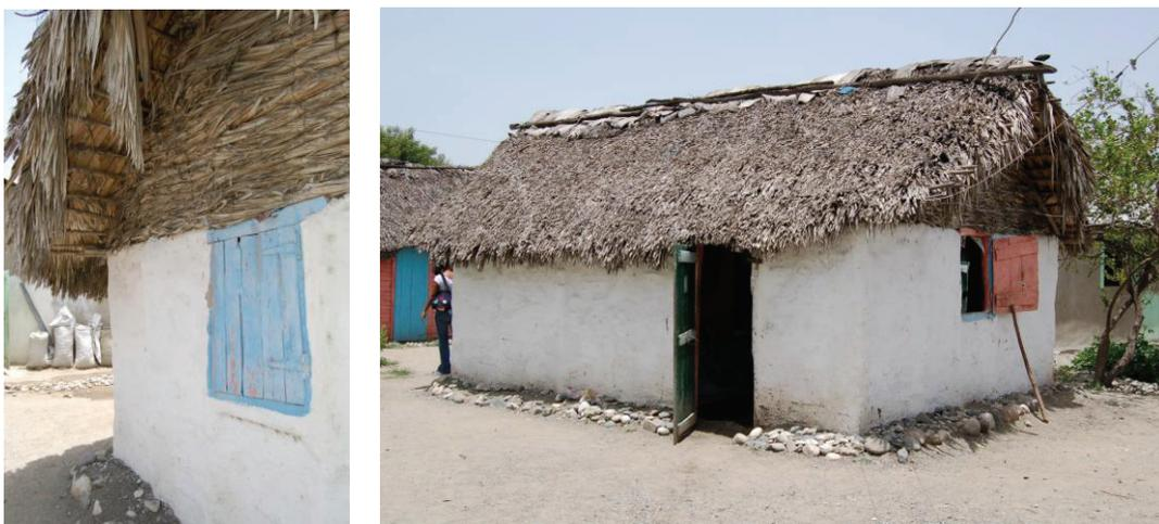
Figura 134. Casas de bajareque con buen mantenimiento, con hastiales o cuchillas con hojas de palma enrolladas. Fotos: EPV
