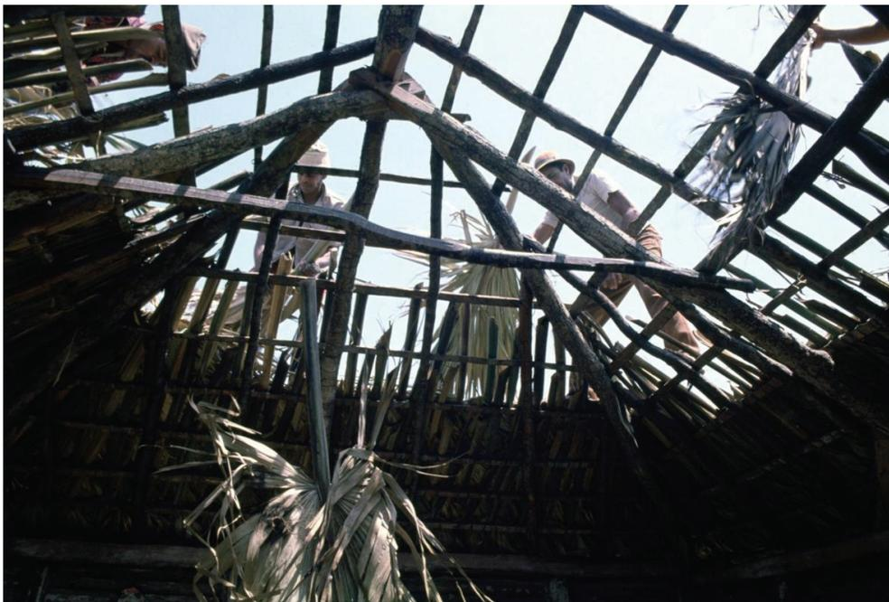
Figura 144. Cobijando un bohío con hojas de palma cana, mediante un convite. Fotos: EPV 1982
