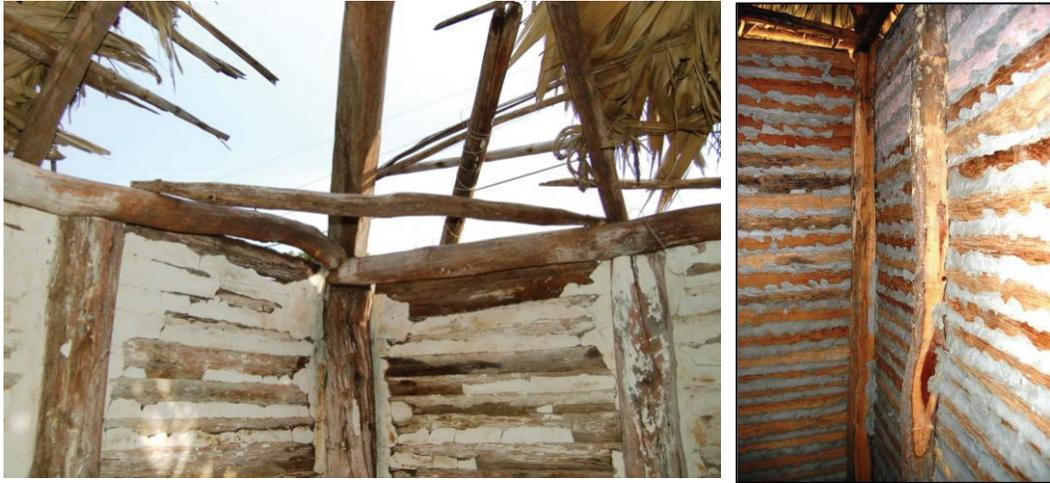
Figura 137. Resanes de las rendijas entre tablas de palma en el interior del bohío.
