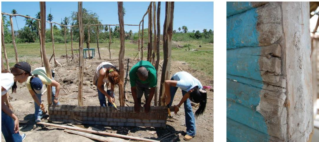
Figura 135. Clavado de las tablas de palma a los horcones y detalle del solape.
