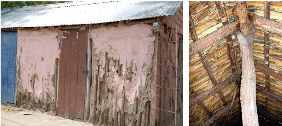
Figura 130. Pared de palos parados con restos de embarrado y pie de amigo soportando la cumbrera de un bohío. Fotos: EPV
