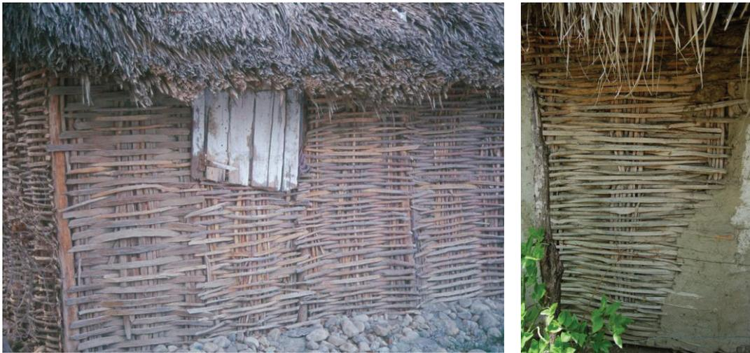
Figura 132. Pared de bajareque y detalle. Fotos: EPV
