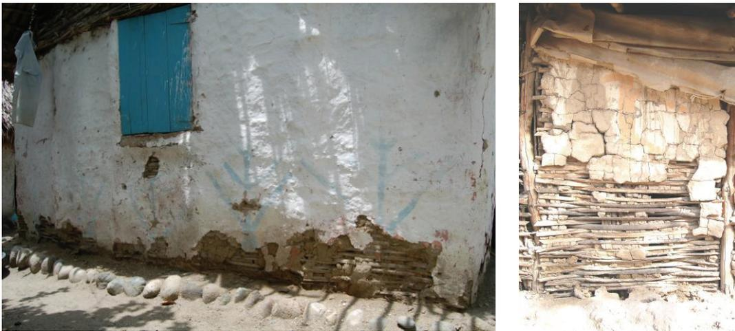
Figura 133. Casas de bajareque con muestras de deterioro del embarrado. A la derecha puede verse un embarrado sin boñiga. Fotos: EPV
