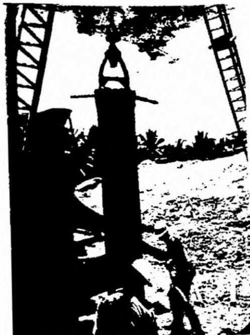
Fig. 3.8 Pilote vaciado in situ.
