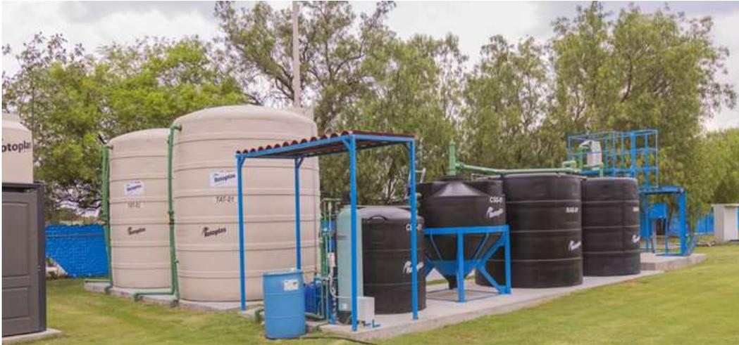
Figura 23. Sistema modular para el tratamiento de aguas residuales. (Rotoplas, 2016).
