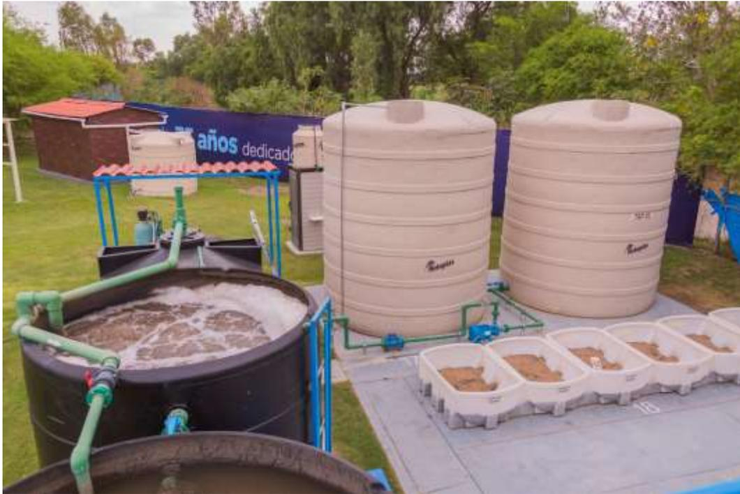
Figura 24. Sistema modular para el tratamiento de aguas residuales. (Rotoplas, 2016).
