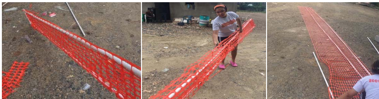
Figura 12. Preparación de la malla con el marco de PVC de \frac{3}{4} ". Fuente: Propia.
