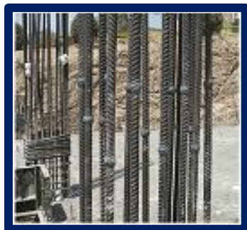
Fig. 6.17 y Fig. 6.18 Empalmes fundidos
