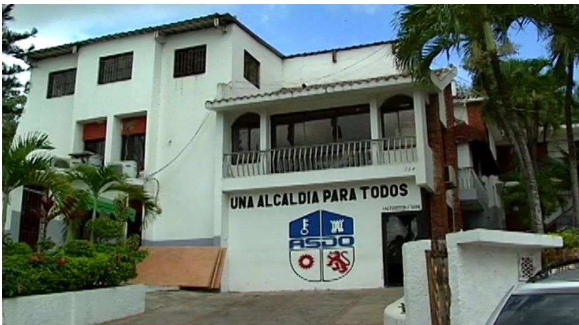
Fotografía 3 Ayuntamiento de Santo Domingo Oeste (ASDO)
